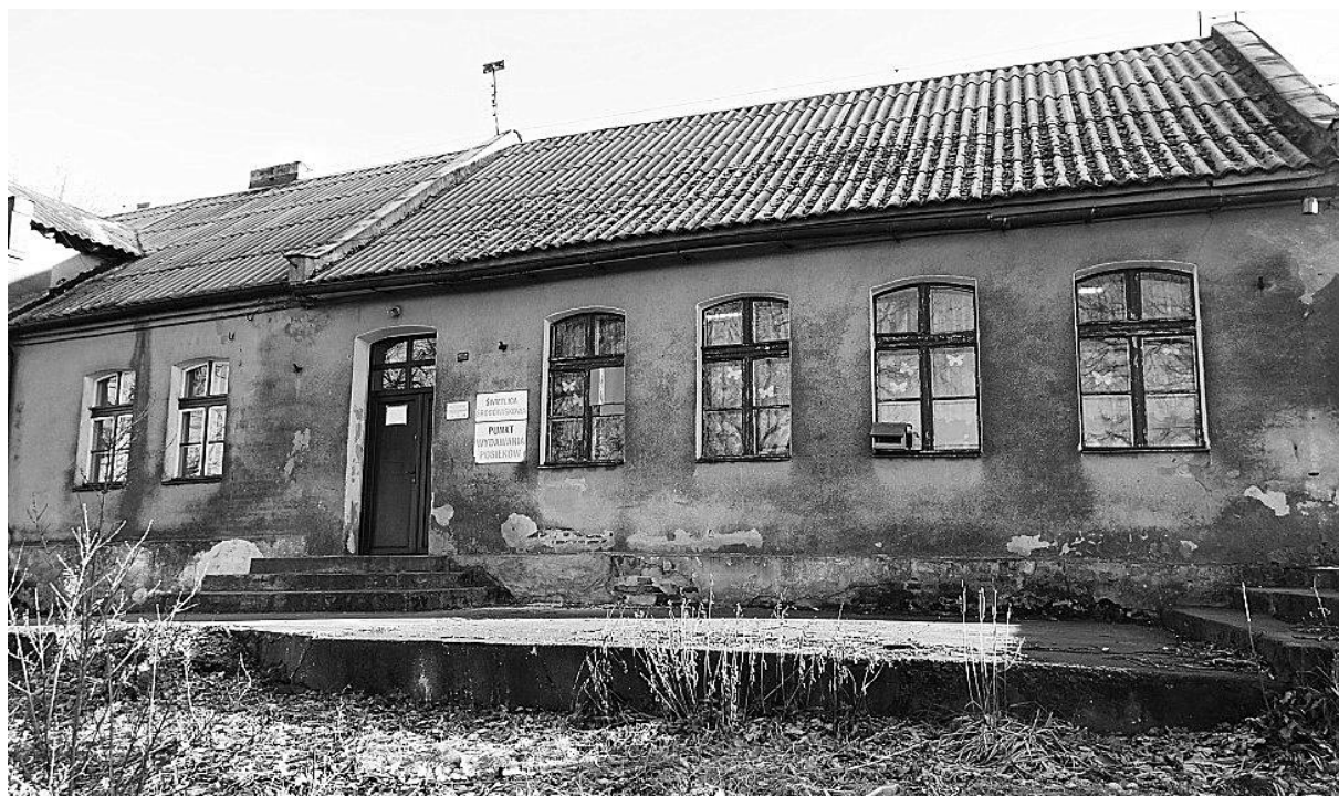
Fotografia 1. Budynek świetlicy wiejskiej w Mgowie
