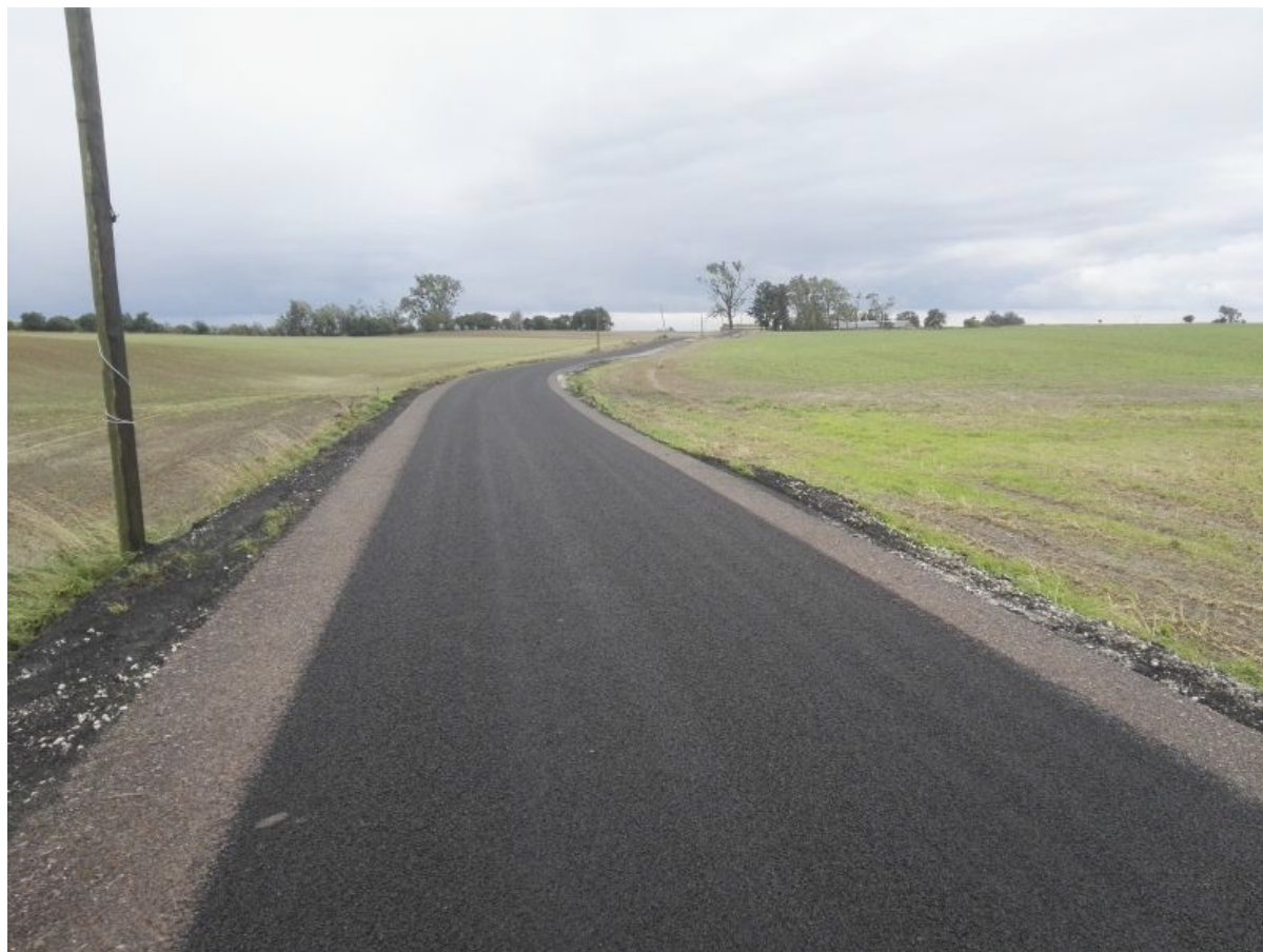
Fot. 5 Przebudowy drogi gminnej Bielawy – Ostrowo
